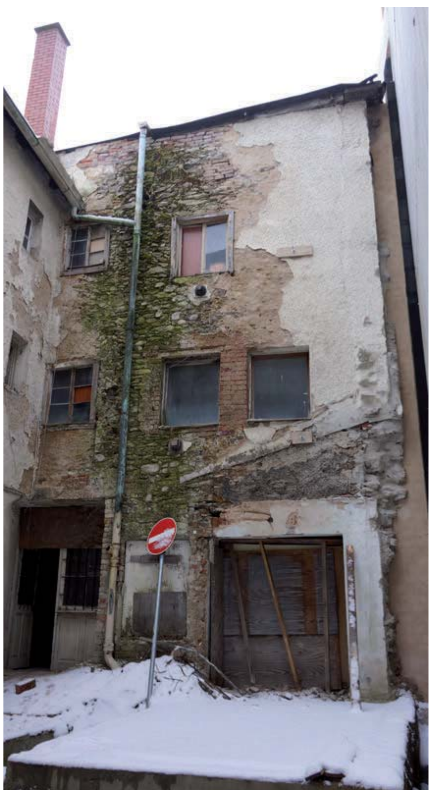
Zustand vor der Sanierung – aussen (Foto: Franz Außerstorfer)
